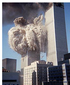
Figure 2: Destruction de la Tour Sud montrant les éjections latérales dans toutes les directions et le rideau de débris qui commence à cacher la vague de démolition (pris peu après 2,20 sec)
